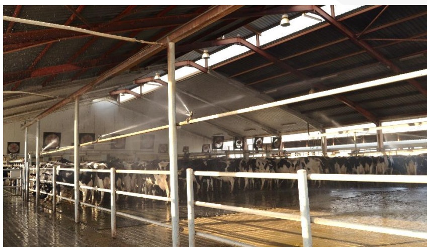
Imagen 4. Sistema de nebulización en granja de vacuno de leche
