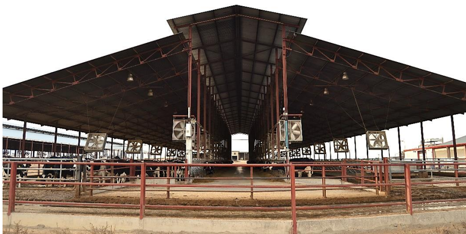
Imagen 3. Sistema de ventilación en granja de vacuno de leche
